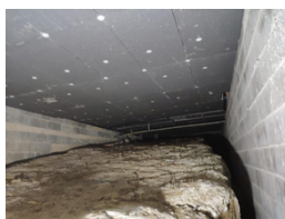
Isolation en sous face de vide sanitaire
