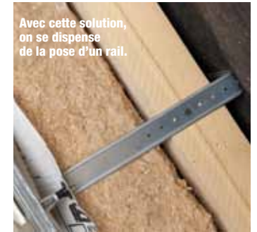
e) Equerre Sixbox® + membrane + Sixbox® + fourrure (vide technique 15 mm à 100 mm)
