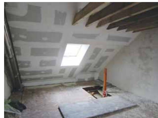
Mise en place du parement (Placo BA13) et plâtrage des mitoyens pour une bonne étanchéité à l'air
