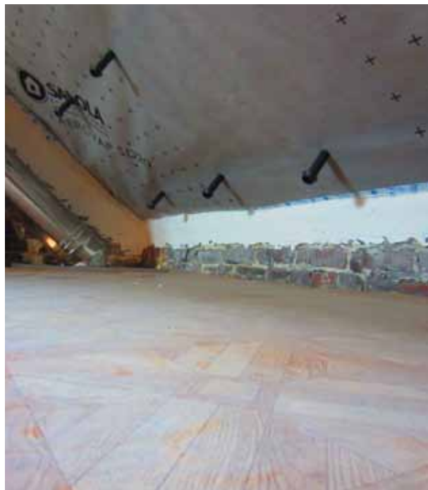
Mise en place du frein vapeur sur les fourrures avec du double face + liaison avec adhésif Contega®/plâtre avec les murs briques
