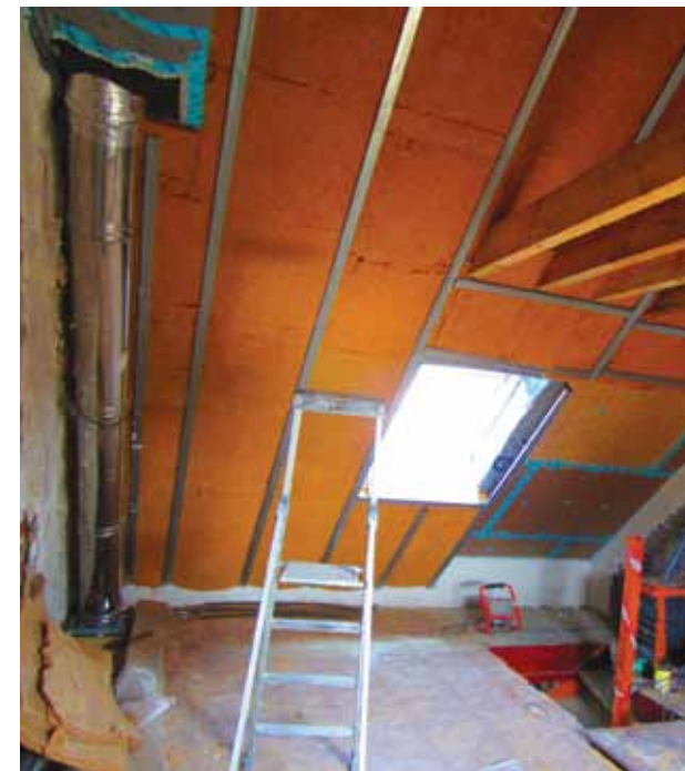
Mise en place d'un patch "spécial" d'étanchéité à l'air autour du conduit de fumée non combustible
