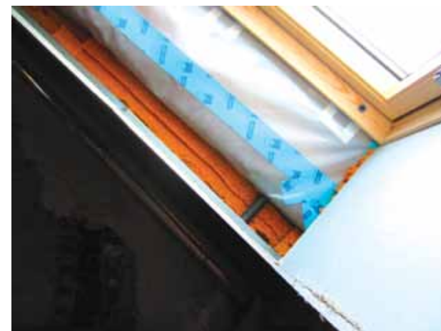
Mise en place de l'isolation du vide technique (fixation Sixbox®) de 8 cm par laine de bois. Au final ce qui fait 8+26+8 = 32 cm d'isolant, R=8,4
