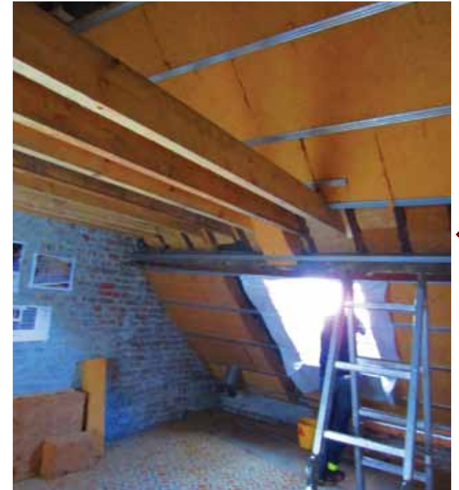
Mise en place des fenêtres de toit avec membrane d'étanchéité à l'air
