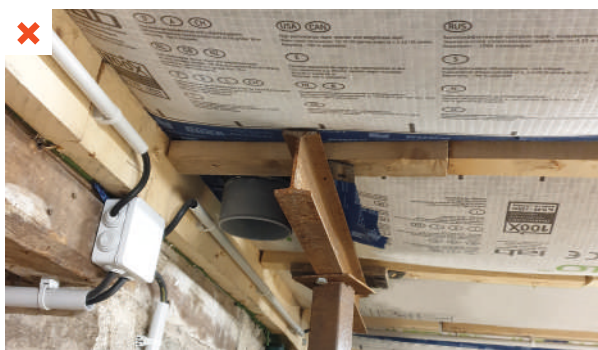
La membrane frein vapeur hygrovariable est positionnée du côté non chauffé de la paroi (isolation d'un plancher bois sur cave par insufflation de ouate de cellulose entre solives). ©AQC
