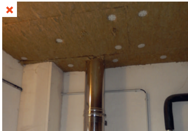
L'isolant non combustible (A1) vient au contact du conduit de fumée métallique. La circulation de l'air autour du conduit n'existe plus. La ventilation de la gaine coupe-feu est obturée.
