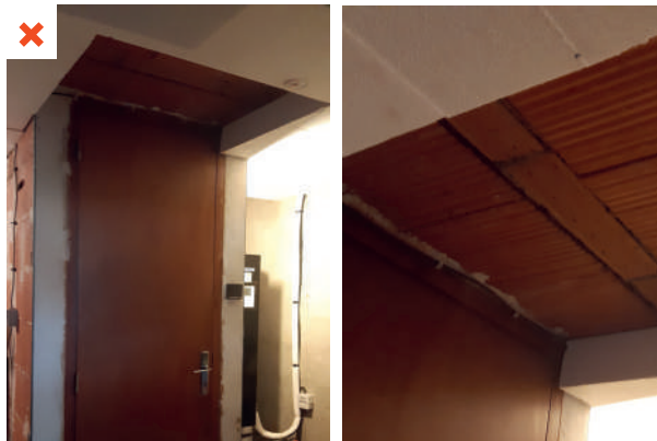
L'isolation du plancher haut du garage s'arrête au niveau de la zone de débattement de la porte d'accès à l'étage de la maison. ©AQC
