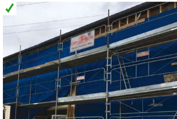
Protection de la façade et de l'isolant avec une bâche contre les intempéries.
